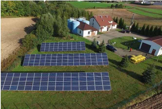
Abb. 3 Microgrid-Demonstrationsanlage in Puńsk.
